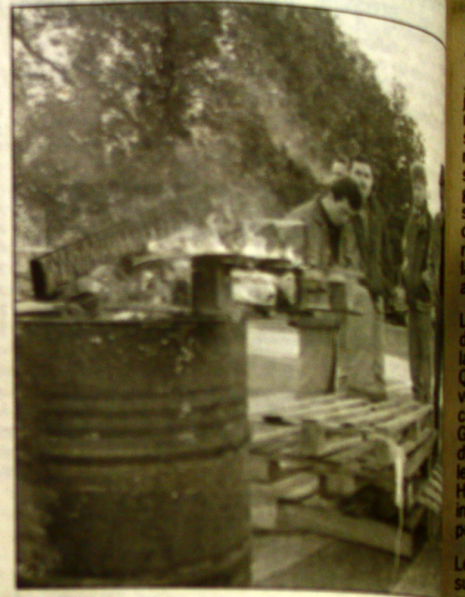
Les « piquets » empêchaient tout accès à l'usine forestoise du premier constructeur automobile européen. Photo Alain Dewez.
